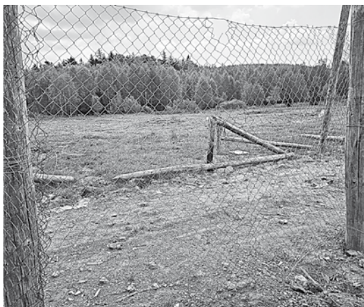
Obrázek č. 12: Protržení plotu po detonaci plastické trhavin LCT 55
