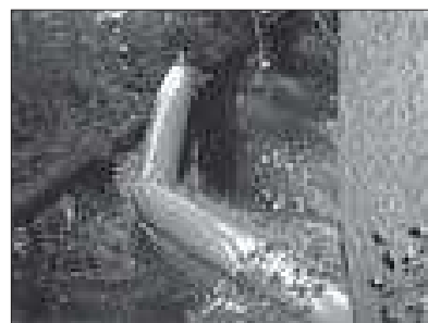
Obr. 27: Norná stěna – zachycení uniklého paliva
