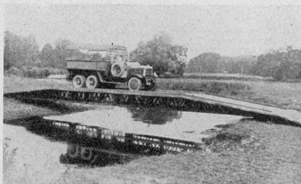
Obr. 2. Článekový příhradový most (Martel).
