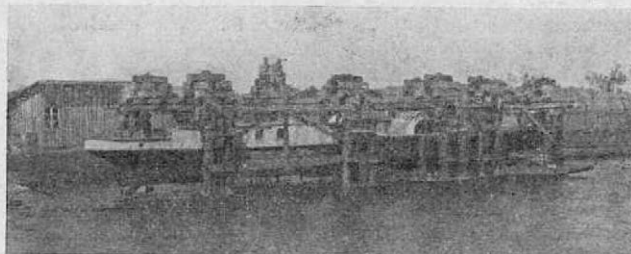
Obr. 1.: Zvedání kolového parníku.
