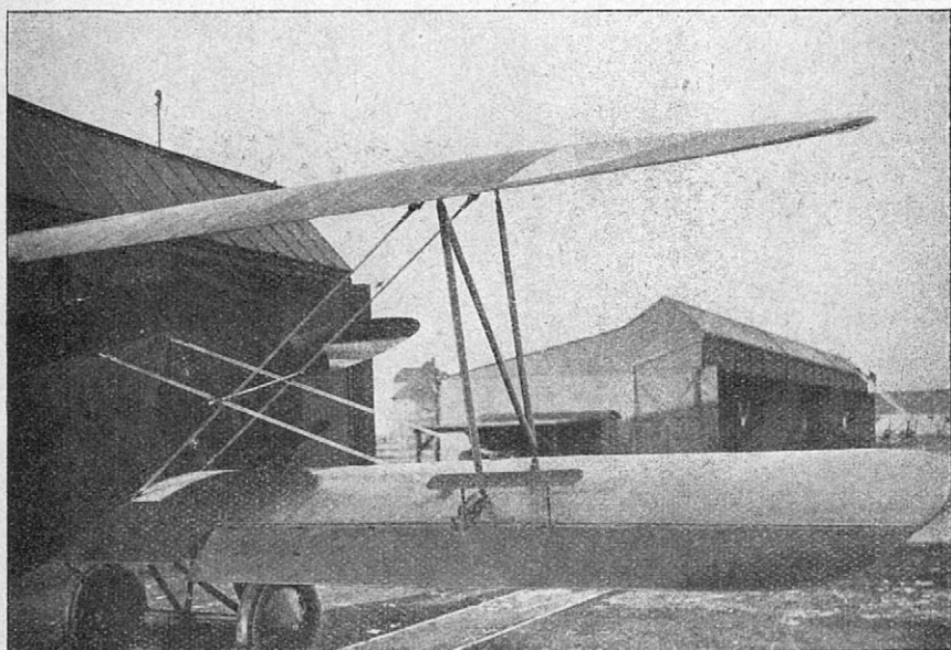
B—33. Jednoduché odlehčené křídélko na dolním křídle.
