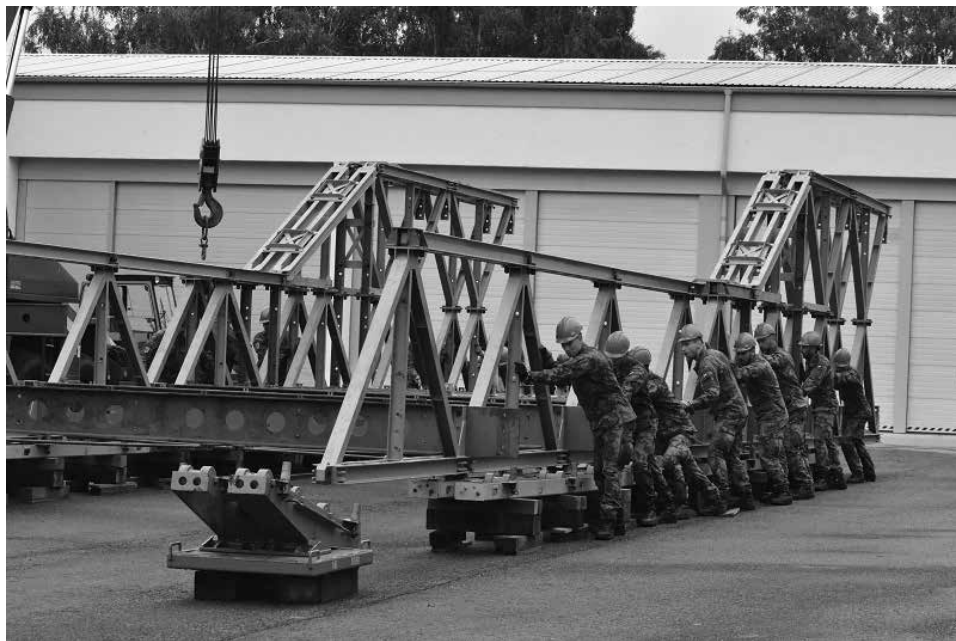
Obrázek č. 6: Cvičná stavba mostu TMS ve skladu SSHR – Soběslav
