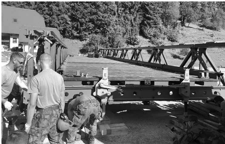
Obrázek č. 9: Ukládání mostní konstrukce pomocí hřebenových zvedáků
