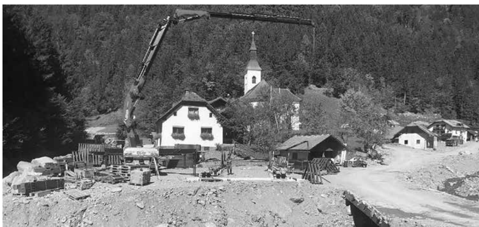
Obrázek č. 12: Výstavba mostu v lokalitě Ljubno ob Savinji
