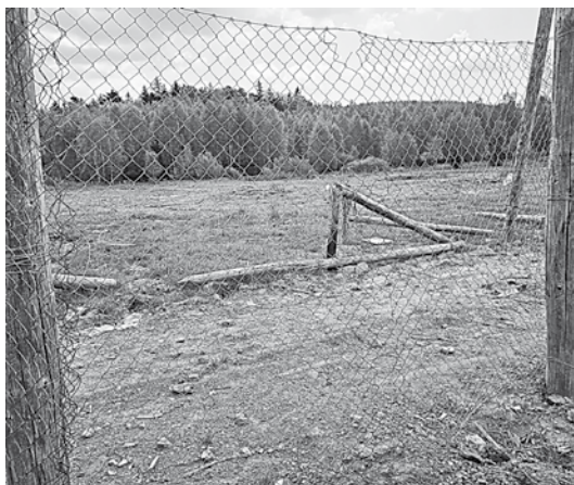
Obrázek č. 12: Protržení plotu po detonaci plastické trhavinu LCT 55
