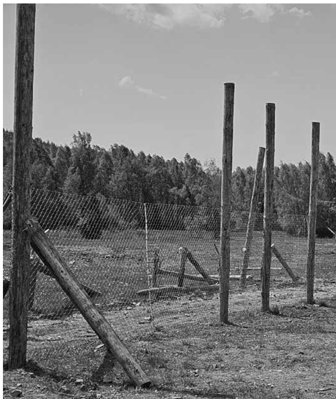
Obrázek č. 5: Instalované pletivo na prvním stanovišti
