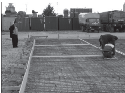
Obr. 2: Uložení karisít a tvorba dilatačních spár
