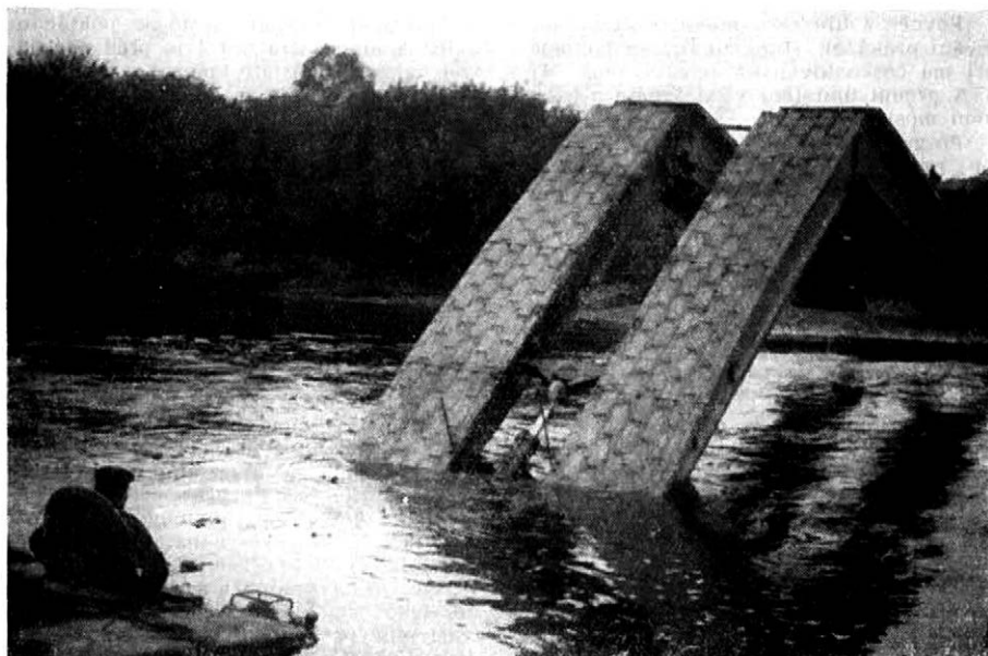
Obr. 2. Pokládání mostu MT-55 A v brodu
