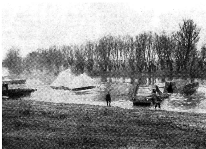
Obr. 5. Spouštění pontonových dílů na vodu (vpravo fáze rozevírání dílu na vodě, vlevo díl při úplném rozevření)
