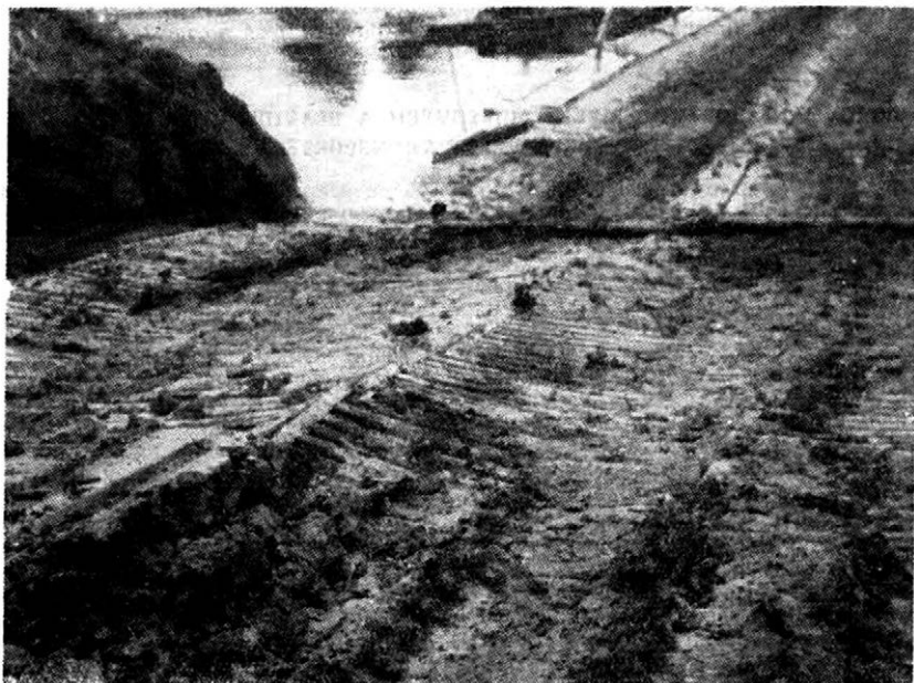
Obr. 2. Upravený přirozený (neregulovatelný) břeh se zpevněním výjezdové plochy s mostu vozovkami PMS
