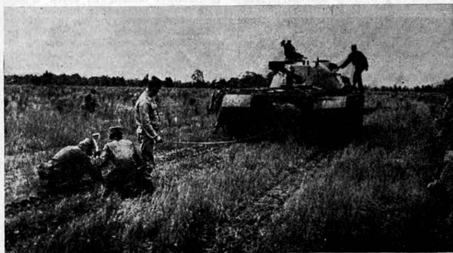
Obr. 2. Členové CORG měří délku prostoru značkováného minového pole, které bylo přejeto tankem
